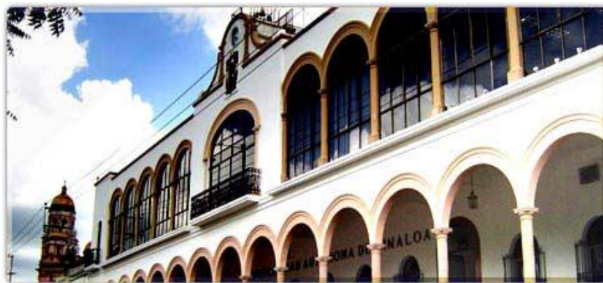
Figura 4.5 Edificio principal UAS
